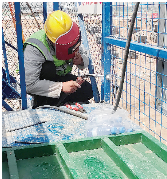
焊接施工现场。
